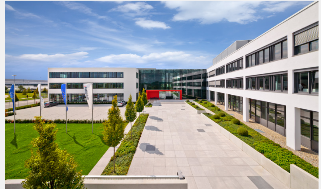
2012–2013 Bau eines neuen Verwaltungsgebäudes und Kernsanierung der bestehenden Verwaltung
