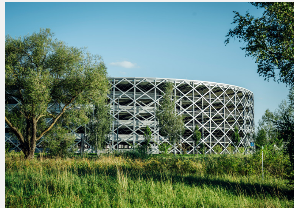
2020 Fertigstellung des Parkhauses mit 1.860 PKW-Parkplätzen
